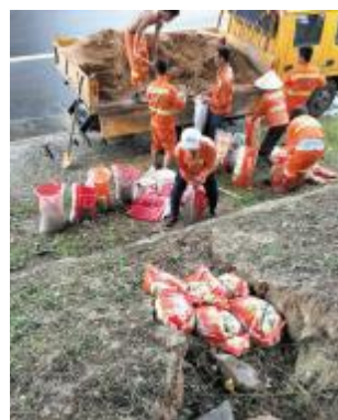
▲工作人员在修路
