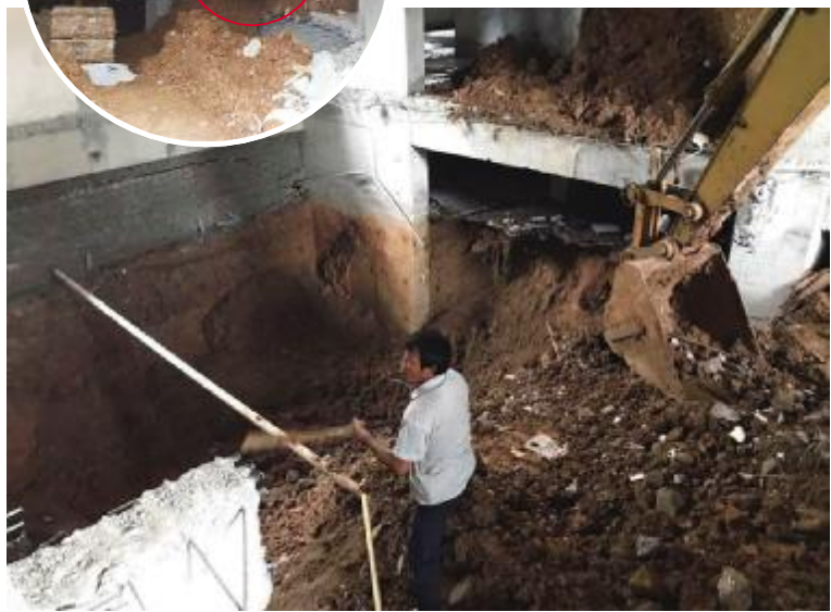
铺面里挖出个5米深的大坑
