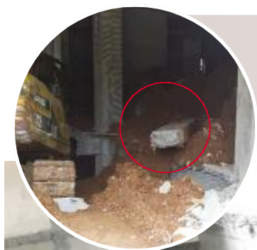
铺面内被拆掉的承重柱
